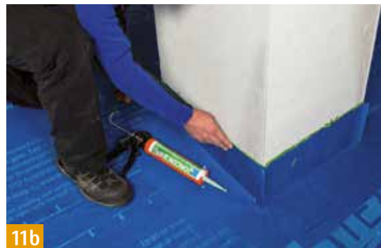
WELDANO INCAV / INVEX Homogen verschweißbares Innen- ecken-/Außenecken-Formteil im SOLITEX WELDANO-Unterdachsystem
