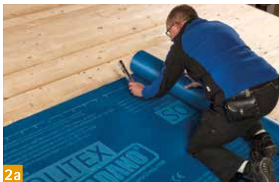
SOLITEX WELDANO Diffusionsoffene, homogen verschweißbare Unterdachbahn
