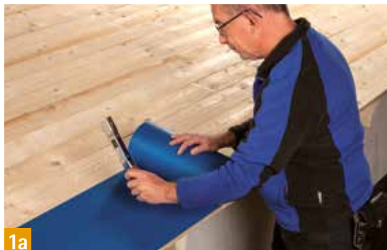
SOLITEX WELDANO-S Diffusionsoffener, wasserdicht verschweißbarer Unterdach- bahnstreifen
