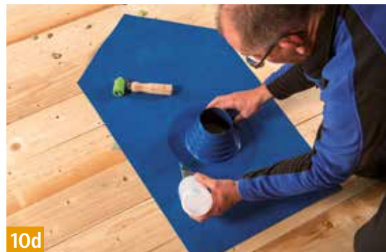
TESCON VANA Zur Verklebung der Bahnen- überlappungen
