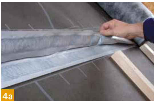
TESCON VANA Allround-Klebeband zur Verklebung der Bahnenüberlappungen
