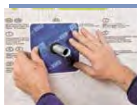
Vorbereiten Untergrund abfeigen, ggf. absaugen oder abwischen.
