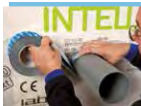
Band abmessen Band in der erforderlichen Länge ausrollen und abschneiden.
