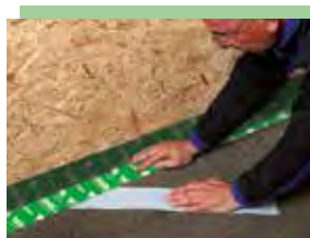
Auf Boden verkleben Zweite Trennfolie nach und nach entfernen und Band Zug um Zug auf dem Boden verkleben.
