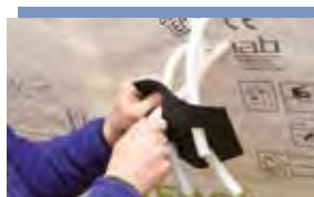
ROFLEX 20 multi Dichtmanschette für 1-9 Rohre oder Kabel mit \varnothing 15-30 mm; EPDM mit Vlies-Klebeband
