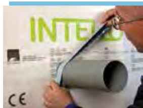
Am Rohr verkleben Band auf dem Rohr ansetzen und Zug um Zug rundum am Rohr verkleben. Auf ausreichende Überklebung der Enden achten.
