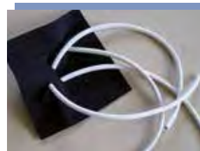
Kabel durchziehen Kabel mit Durchmessern von 6-12 mm durch die zuvor erstellten Löcher in der EPDM-Manschette ziehen.
