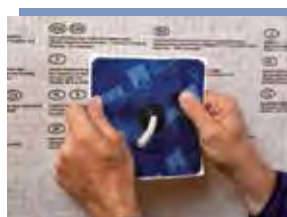
Kabel durchziehen und ausrichten Kabel durch das vorgestanzte Loch im EPDM ziehen und ausrichten. Geeignet für Kabel mit Ø 6-12 mm.
