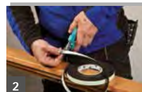
2 Anfang abschneiden Ein Stück CONTEGA FIDEN EXO abrollen und den überkomprimierten Anfang des Bandes (ca. 2 cm) abschneiden.
