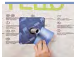
Verkleben Flächig auf zu dichtenden Untergrund führen, verkleben, fest anreiben. Fertig.
