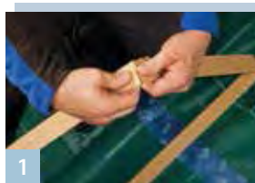
Von Hand ablängen DASATOP FIX einfach in der gewünschten Länge abbrechen.
