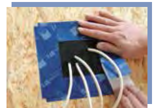
Manschette verkleben Manschette flächig auf zu dichtenden Untergrund führen, Untergrund reinigen und mit TESCON VANA oder TESCON No.1 verkleben. Klebeband fest anreiben. Fertig.
