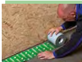
Band ausrollen Band in der erforderlichen Länge ausrollen.
