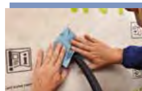
Anschlüsse an Leerrohr ... Einfacher Anschluss an Leerrohren oder Kabeln bis ø 40 mm mit TESCON INVEX Formteil, z. B. dann, wenn deren Enden ...
