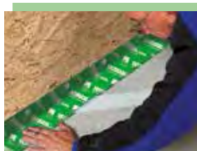
Verkleben auch auf Beton EXTOSEAL FINOC kann auch direkt auf Beton geklebt werden. Falls erforderlich Untergrund mit TESCON PRIMER RP vergüten.
