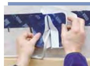
Auf Untergrund verkleben Unteres Trennpapier Zug um Zug entfernen. Manschette flächig auf zu dichtenden Untergrund führen und rundum verkleben. Verklebung fest anreiben.
