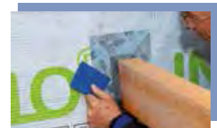
Umlaufend einkleben Anschließend mit dem Eckklebeband TESCON PROFIL verkleben. Fertig
