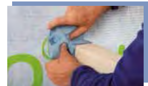
Verkleben an Durchdringung Auf verbliebenen Trennfolien in die Ecke schieben und auf Durchdringung, z. B. Balken, verkleben.
