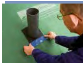
Einsatz auch im Außenbereich Alle ROFLEX-Manschetten können auch im Außenbereich, z. B. bei der Aufdachdämmung, eingesetzt werden. Wichtig ist dabei die Verwendung der Systemklebebänder TESCON VANA oder TESCON No.1 mit wasserfestem SOLID-Kleber.
