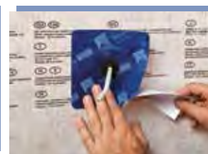
Trennpapier lösen Trennpapier Stück für Stück ablösen.
