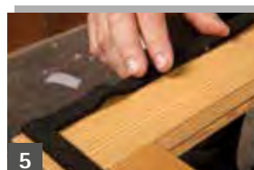
5 Ecken stumpf stoßen Band umlaufend auf den Blendrahmen kleben. Dabei pro Seite je einen Zuschnitt CONTEGA FIDEN EXO verwenden und die Ecken stumpf stoßen. Im Eckbereich leicht stauchen.
