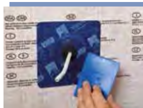
Manschette verkleben und fest anreiben Manschette auf dem Untergrund verkleben und fest anreiben. Dabei auf ausreichenden Gegendruck achten. Besonders effizientes und Händeschonendes Anreiben mit der Anpresshilfe pro clima PRESSFIX.
