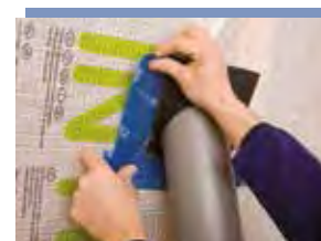
ROFLEX verkleben und fest anreiben Manschette auf dem Untergrund verkleben und fest anreiben. Dabei auf ausreichenden Gegendruck achten. Besonders effizientes und schonendes Anreiben mit der Anpresshilfe pro clima PRESSFIX.
