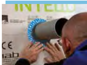
Fest anreiben AnschlieBend Verklebung überall fest anreiben. Auf ausreichenden Gegendruck achten. Besonders effektiv und händeschonend mit der Anpresshilfe pro clima PRESSFIX.
