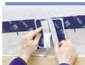
Manschette ausrichten Manschette mit dem Schlitz um das Kabel führen und ausrichten.
