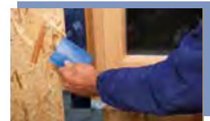
Leibung umlaufend verkleben Zum Schluss Leibung umlaufend, z. B. mit TESCON VANA verkleben. Fertig
