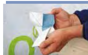
Eckige Durchdringung Trennfolienstreifen an den ersten beiden Schenkeln entfernen.
