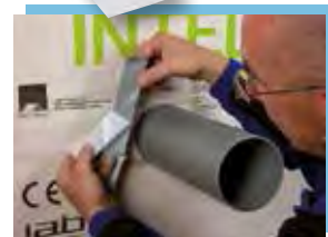
Erste Trennfolie entfernen Band mittig falten und erste Trennfolie entfernen.
