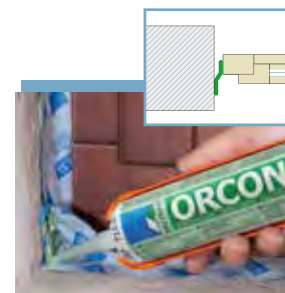
Mauerwerks-/Betonbau, CONTEGA seitlich am Blendrahmen
