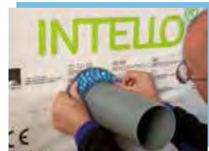
Auf Fläche verkleben Zweite Trennfolie komplett entfernen. Band nach und nach auf die Fläche klappen und Zug um Zug umlaufend verkleben.
