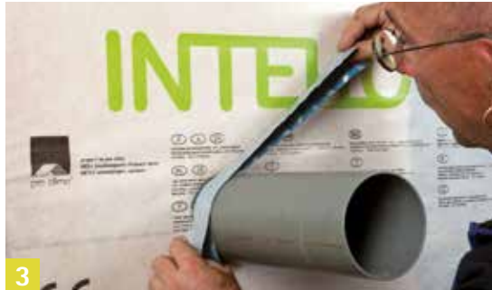
3 Am Rohr verkleben
