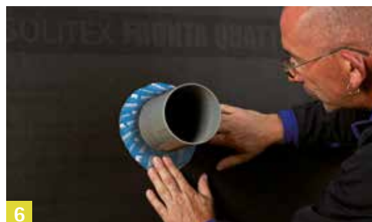
6 Einsatz auch außen
