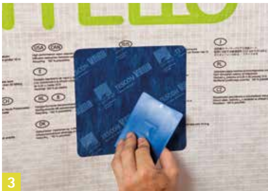
3 Mit der Anpresshilfe pro clima PRESSFIX fest anreiben
