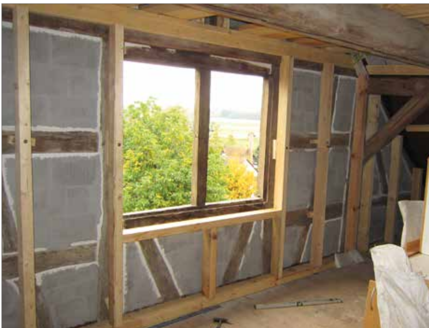
Innenputz bei Riegelwand, nachgebessert: Die Anschlussfugen zwischen Ausfachung und Riegel wurden sorgfältig nachgebessert, damit der Schlagregen nicht mehr so leicht eindringen kann
