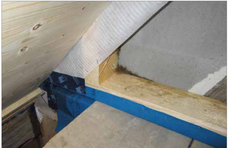
Durchgängige Luftdichtung am Deckenaufleger
