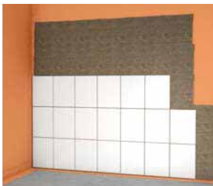
Verfliesung mit fermacell Flexkleber
