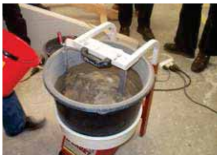
Anmischen fermacell Quellschlamm
