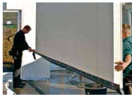
Absetzen der Wandtafel im Mörtelbett
