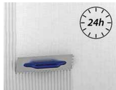
Aufbringen der zweite Putzschicht 2–3 mm fermacell HD Leichtmörtel nach Erhärten der Armierungsschicht (Variante A)
