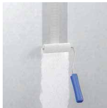
Aufrollen des fermacell Armierungsklebers HD
