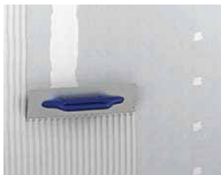
Aufbringen des fermacell Leichtmörtels HD mit 5–6 mm Schichtdicke für den Grundputz
