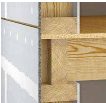
Bild 3: Mit HD-Fugentechnik versehener Bereich des Plattenstreifens
