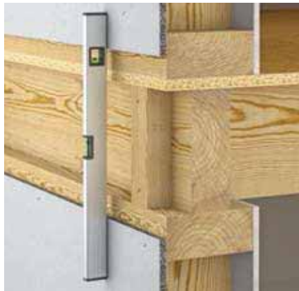
Bild 1: Ausrichten der Wandelemente
