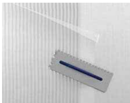
Überlappung des Armierungsgewebes mit ca. 100 mm
