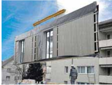
Krantransport auf der Baustelle
