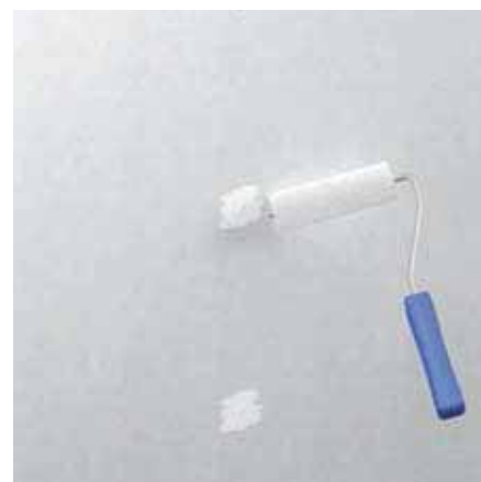
Deckendes Abtupfen der Verbindungsmittel in der Plattenfläche
