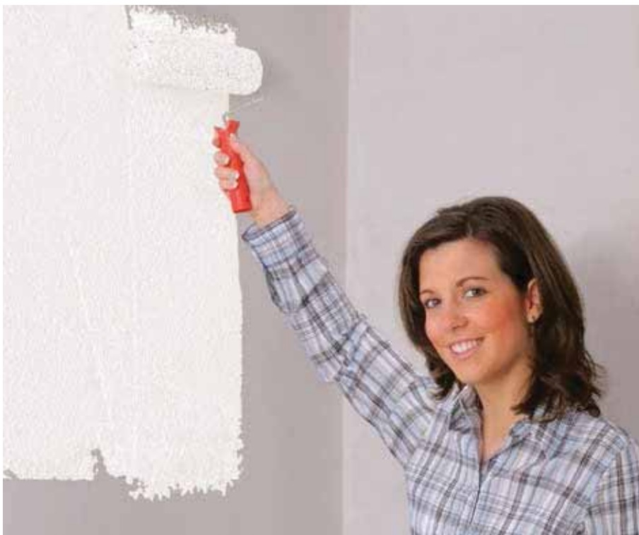
fermacell Rollputz ist mit Dispersions-, Latex-, Acryl- und Silikonharzfarben überstreichbar.
