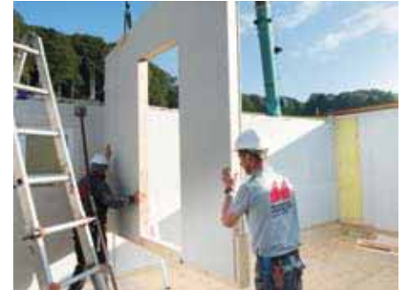
Montage auf der Baustelle
