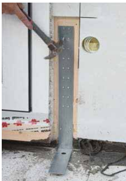
Montage Zuganker (Verdübelung Lastplatte noch nicht erfolgt)
