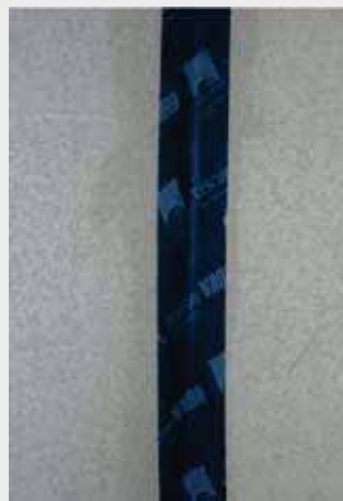
Luftdichte Abklebung einer Innenecke auf fermacell Vapor mit Primer
