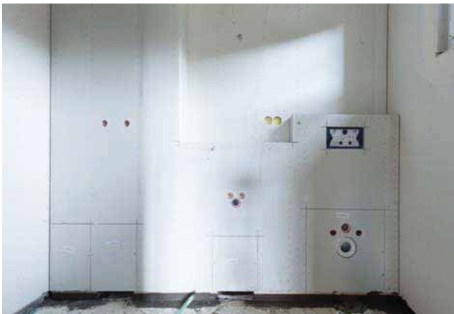
Tragständer für wandhängende WCs mit Einbauspülkästen
