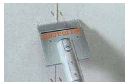
Entfernen des überschüssigen Klebers mit fermacell Klebstoffabstoßer
