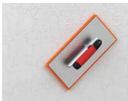
Abfilzen der Putzoberfläche mit einer Schwammscheibe
