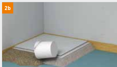
Variante B: Man zieht in Höhe der Oberkante des Ablaufgehäuses die gesamte Fläche mit der gebundenen Schüttung ab und setzt das Duschelement
