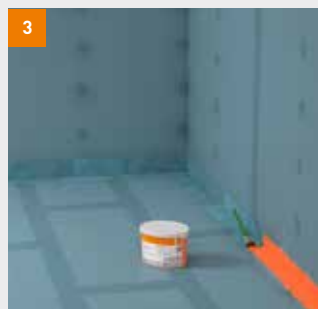
3 fermacell Flüssigfolie in der Ecke auftragen
