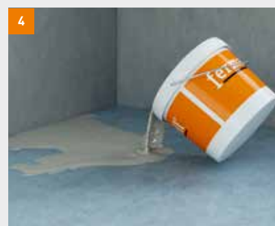
Boden-Nivelliermasse ausbringen und planeben nivellieren
