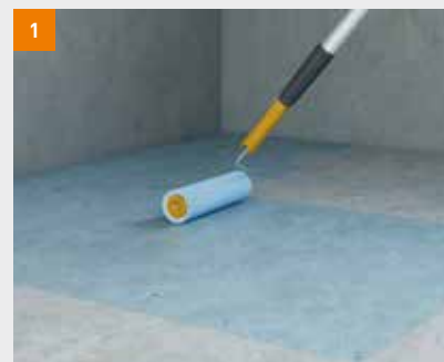
Vorbereitung: Boden grundieren
