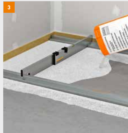
fermacell Ausgleichsschüttung einbringen
