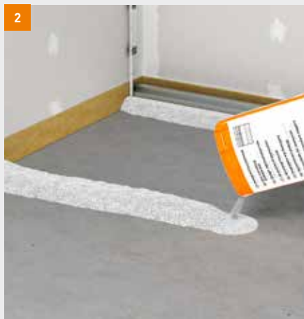
Anlegen der Dämme
