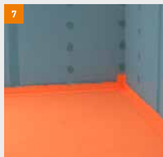
7 Bei der Verwendung von Gipsfaser Estrich-Elementen im Bereich A0 muss zusätzlich eine vollflächige Abdichtung erfolgen
