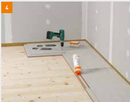
4 Auftragen des fermacell Estrich-Klebers im Falzbereich
