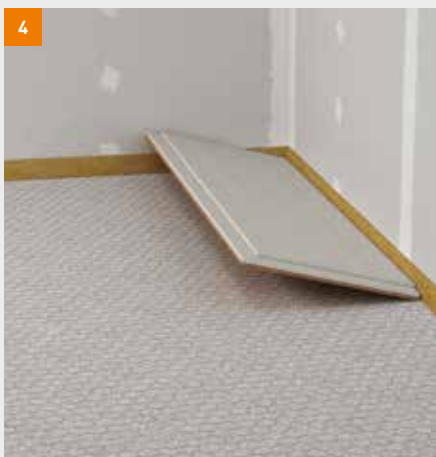
fermacell Estrich-Elemente verlegen
