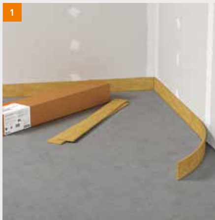
Anbringen der Randdämmstreifen
