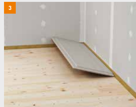
3 Verlegen der fermacell Estrich-Elemente
