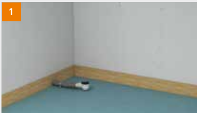
Nachdem die Lage des Duschelements markiert ist, wird das Ablaufgehäuse gesetzt
