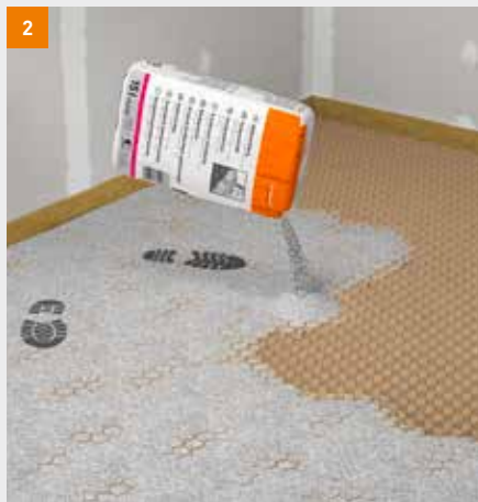
fermacell Wabenschüttung einbringen
