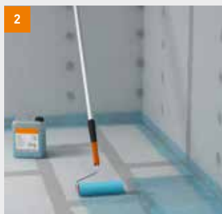
2 ... und Bodenbereich per Rolle auftragen
