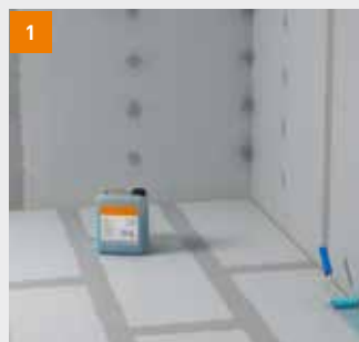
1 fermacell Tiefengrund im angrenzenden Wandbereich ...
