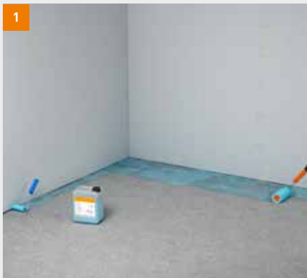
1 Grundierung des Untergrundes mit fermacell Tiefengrund
