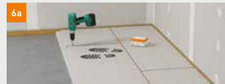
3 Verlegen der fermacell Estrich-Elemente
