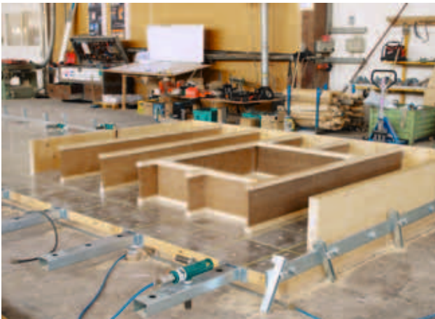
Die Rippen (STEICOWall und STEICO LVL) der Wandtafel werden nach Plan zusammengefügt.
