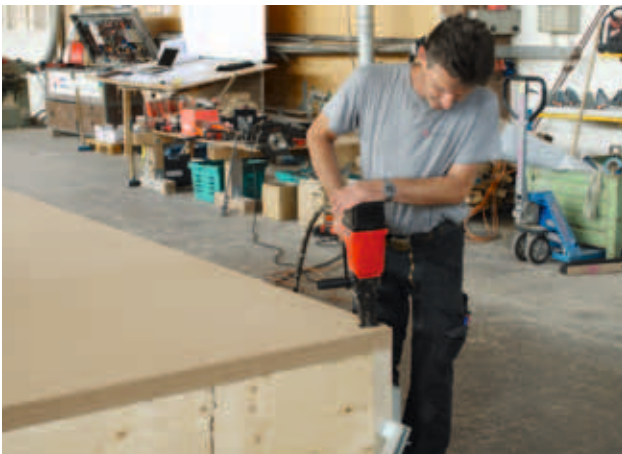
Befestigung von STEICOprotect H mit Edelstahl-Breitrückensklammern.
