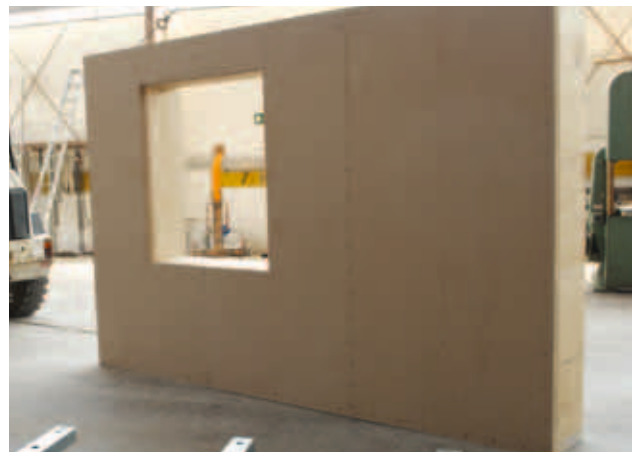
Aussenansicht. Vor Witterung schützende Wandtafel, bereit für die Baustellenmontage.
