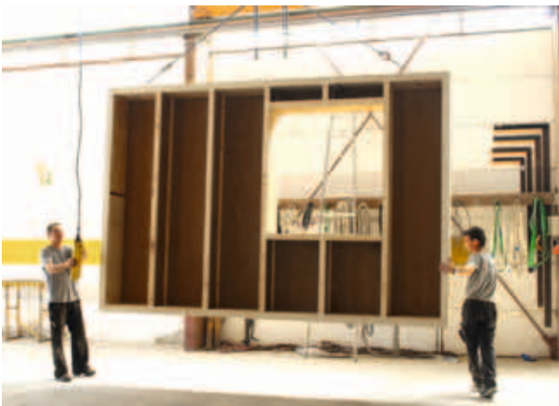
Fertiges Element am Kran. Wirtschaftliche und schnelle Fertigung mit geringem Personaleinsatz.
