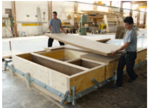
Bepunktung mit STEICOprotect H. Aussteifung während der Bauphase und Witterungsschutz.
